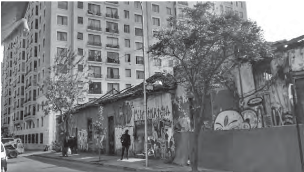
Redesarrollo en altura y deterioro circundante. Fotografía tomada por el autor.
